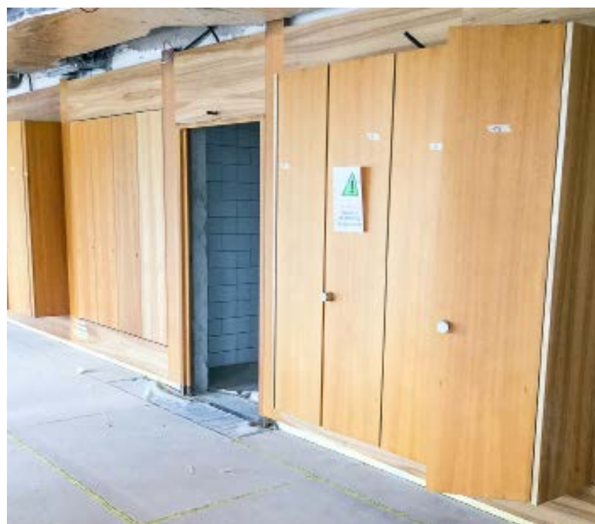
Die Wandschränke im AXA-Gebäude nach dem Wiedereinbau.
